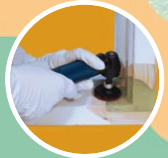
6. Ausgehärtetes DRY FLEX® schleifen
