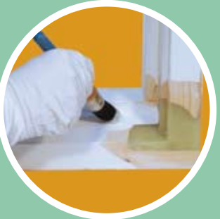
7. Beschichtungssystem auftragen
