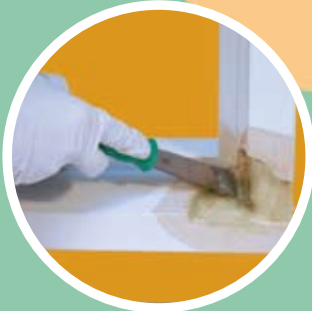
4. Reparaturkontaktstellen mit DRY FLEX® schließen
