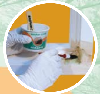
3. Reparaturkontaktstellen mit DRY FIX® festigen
